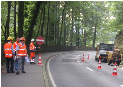
Fonte: Scheda tematica Suva codice 33076: «Indumenti ad alta visibilità per i lavori sulle strade pubbliche»
